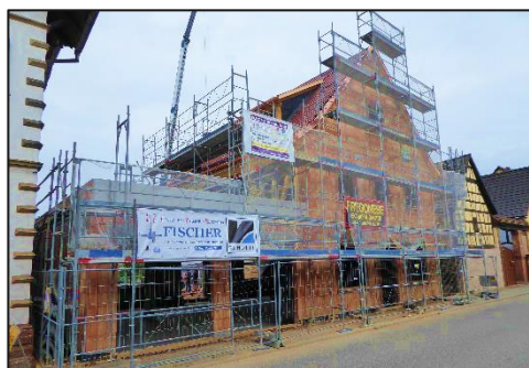
Reconstruction maison Heschung (travaux de charpente en cours)
