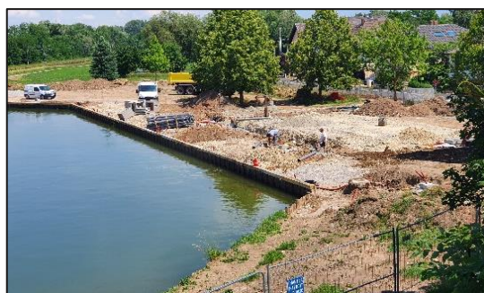
Aménagement du bassin canal (travaux de terrassement et de réseaux secs pratiquement achevés)
